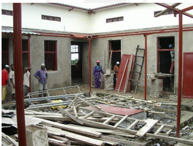
Le chantier de la nouvelle infirmerie que nous allons équiper
